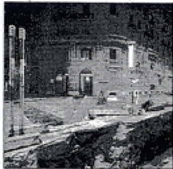
Un cantiere di via Melchiorre Gioia
